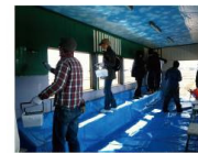
駅舎の内部の様子
